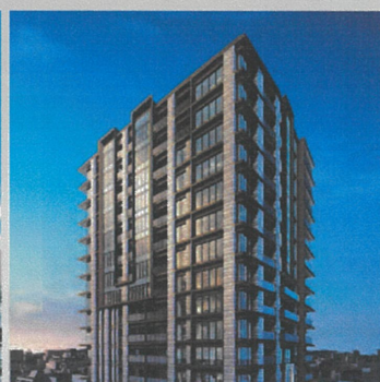
レーベン福岡天神 ONE TOWER 所在地/福岡県福岡市中央区天神5 総戸数/153戸 竣工/2024年2月
