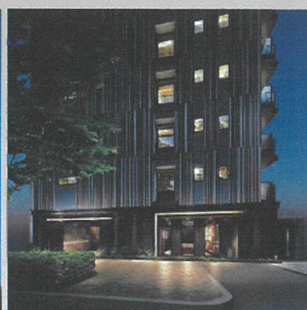
ネベル大阪上本町 所在地/大阪府大阪市天王寺区上本町3 総戸数/98戸 竣工/2020年6月
